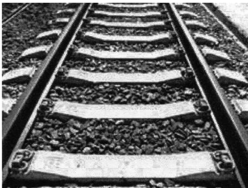
Рис. 33. Рельсовое крепление
