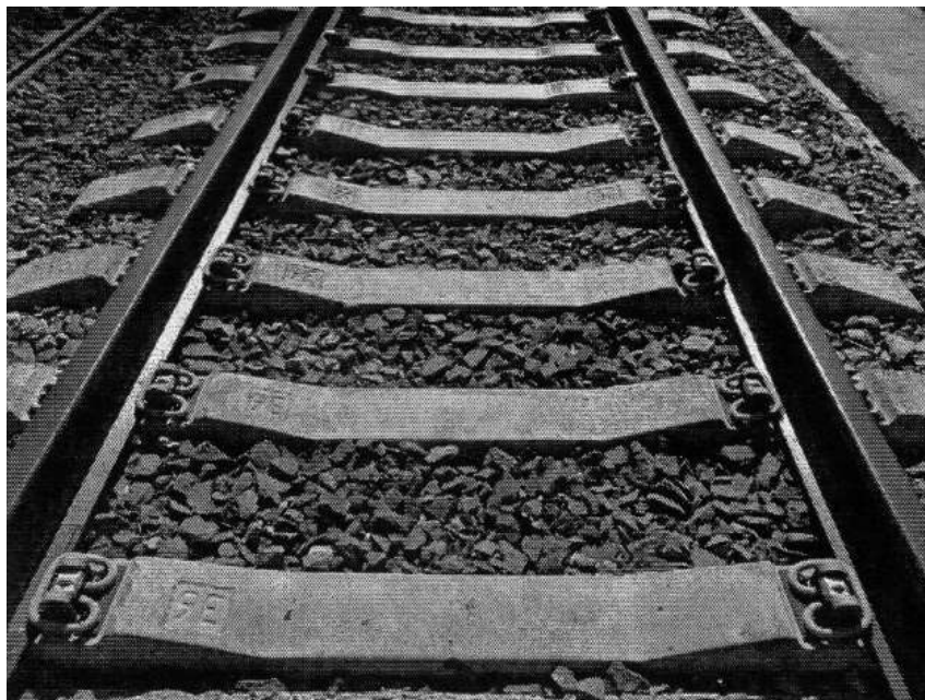
Рис. 6. Участок железнодорожного пути
