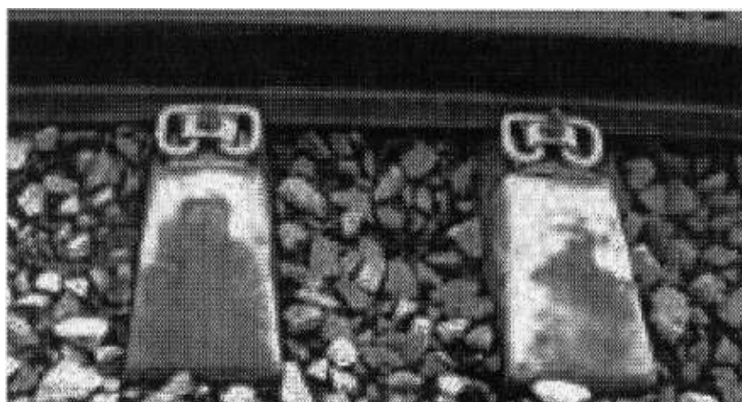
Промежуточное рельсовое скрепление
