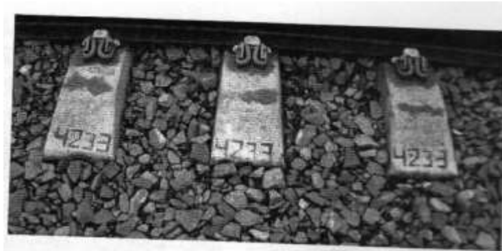
Рис. 26. Рельсовое крепление
