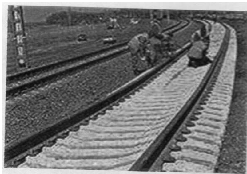
Рис. 20. Конструкция бесстыкового железнодорожного пути в кривом участке
