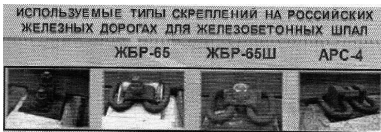
Рис. 8. Типы рельсовых креплений
