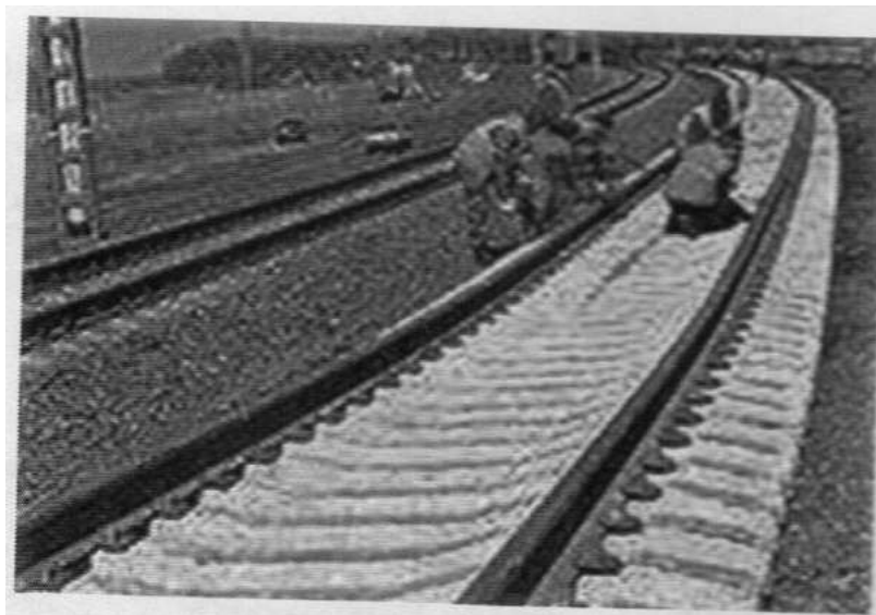
Рис. 20. Конструкция бесстыкового железнодорожного пути в кривом участке
