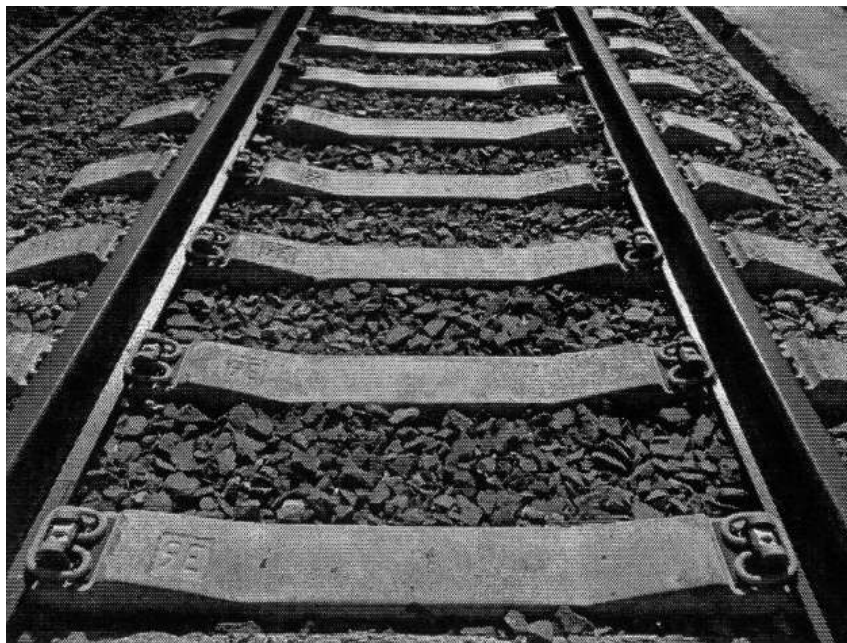
Рис. 6. Участок железнодорожного пути
