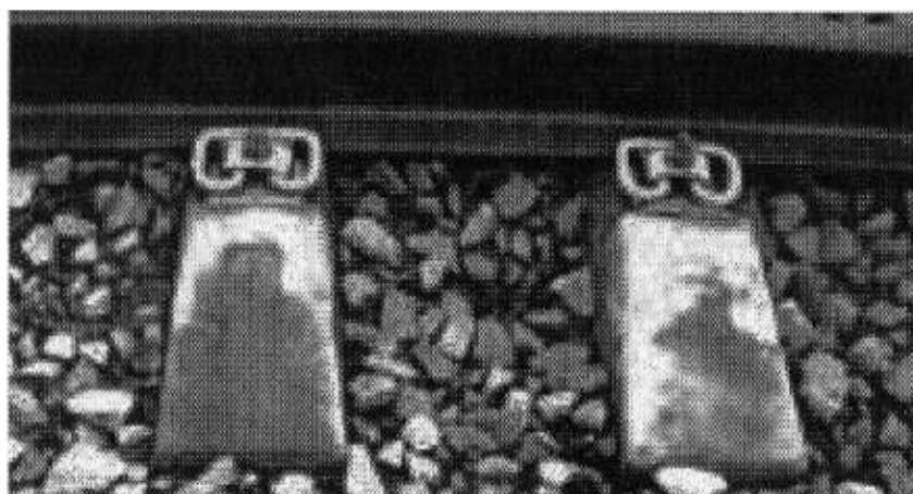
Промежуточное рельсовое скрепление
