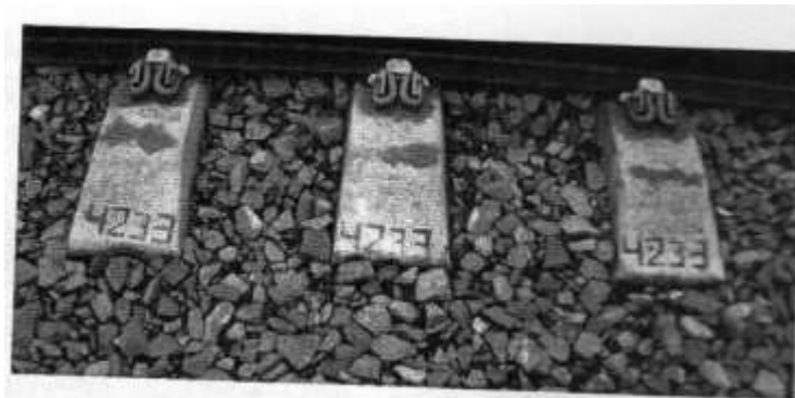
Рис. 26. Рельсовое скрепление
