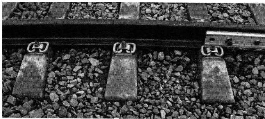
Рис. 12. Рельсовое скрепление
