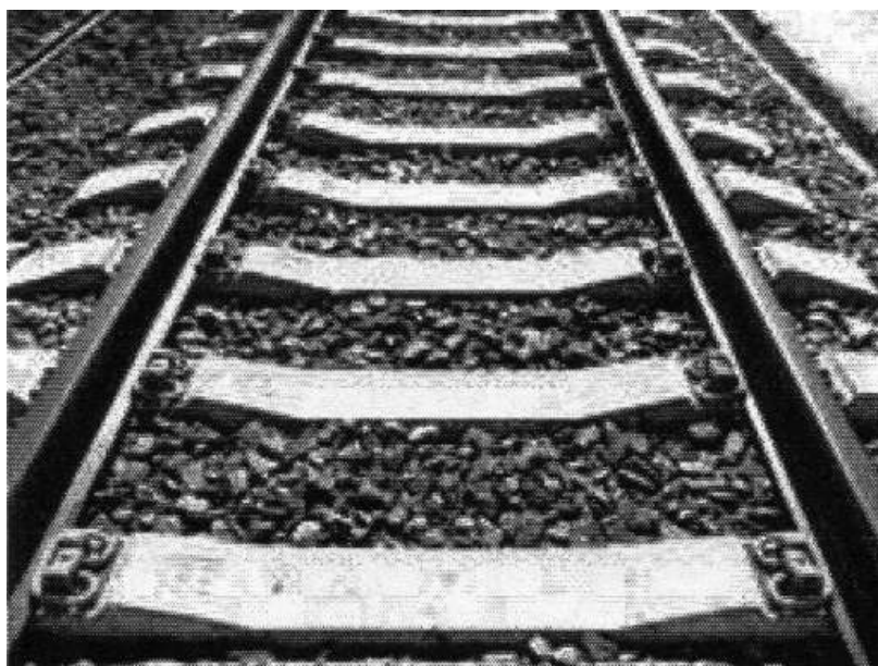
Рис. 33. Рельсовое крепление
