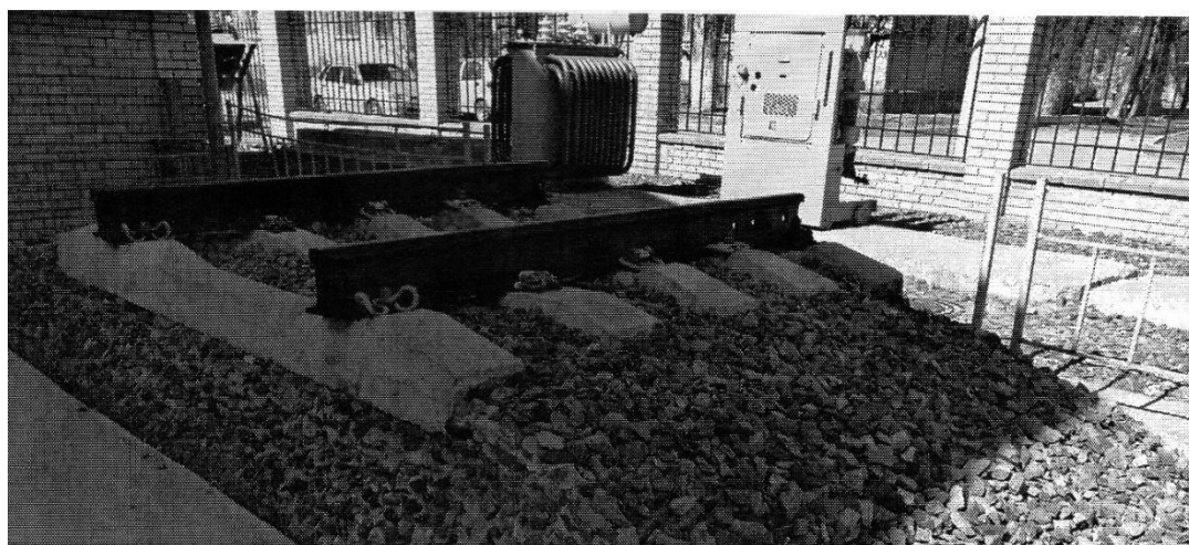
Рис. 10. Разрез железнодорожного пути
