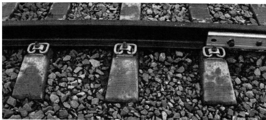
Рис. 12. Рельсовое крепление
