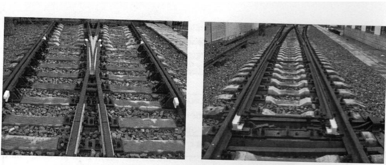
Рис. 19. Обыкновенный стрелочный перевод
