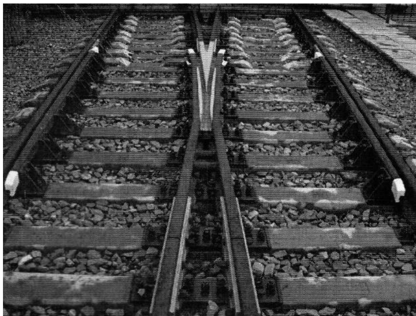
Рис. 5. Элемент стрелочного перевода
