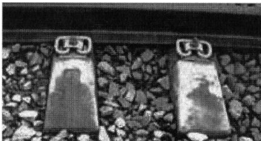
Промежуточное рельсовое крепление
