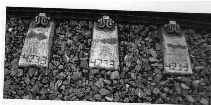
Рис. 26. Рельсовое крепление
